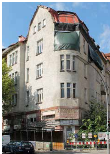
Das leerstehende Haus Gardeschützenweg Ecke Hindenburgdamm
